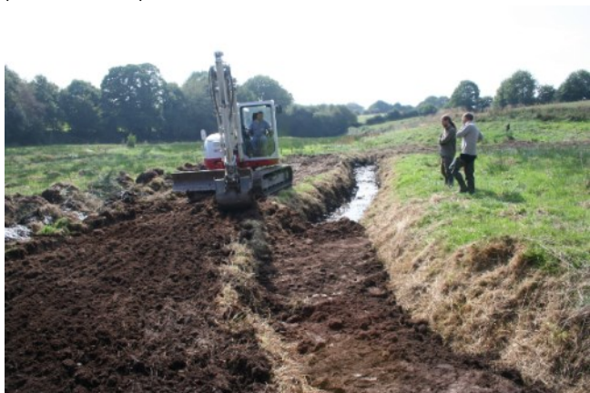
Comblement des fossés de drainage
