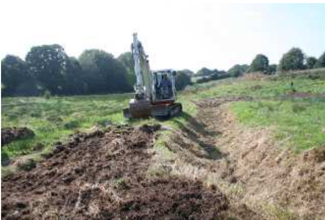
Décapage du haut des berges
