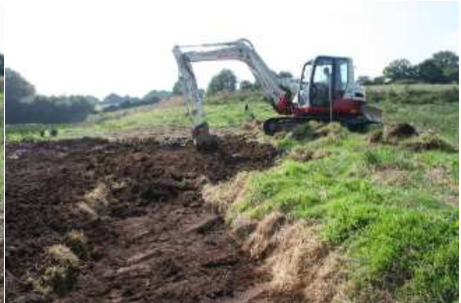
Comblement total du fossé
