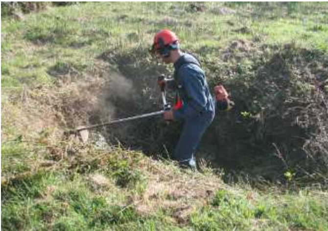
Fauche 10 jours avant travaux
