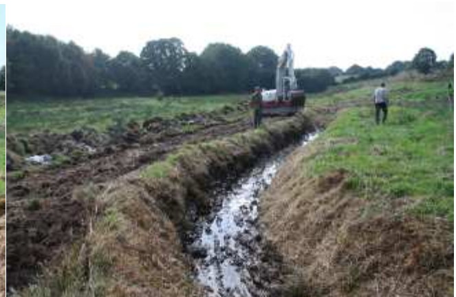
Curage du fond du fossé
