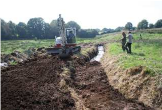
Dépôt des anciens matériaux de curage dans le fossé et léger tassement mécanique
