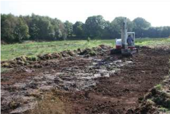
Régalage en surface des boues de curage
