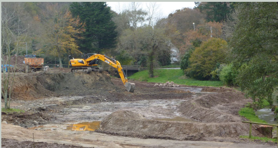
Illustration d'un merlon maintenu en bord de cours d'eau et d'un bassin tampon permettant d'éviter le départ des sédiments vers le cours d'eau durant le chantier. La pelle mécanique reste sur le remblai pour réaliser le décaissement et éviter de tasser le sol de la zone humide (© Brest Métropole).
