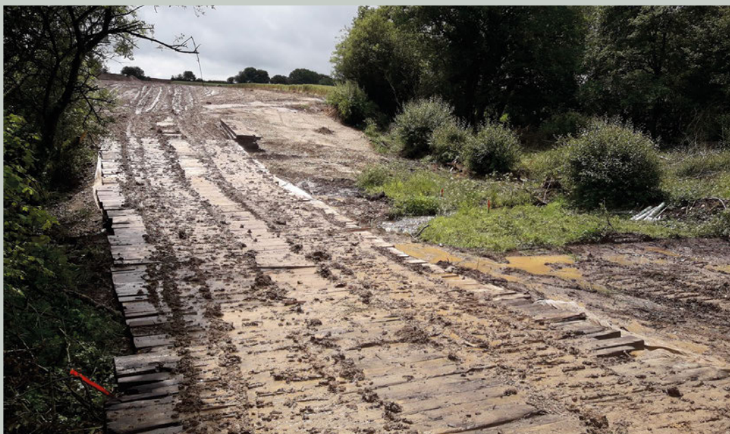
Plats-bords mis en place pour limiter l'impact du passage d'engins lourds sur le sol de la zone humide (© OFB).
