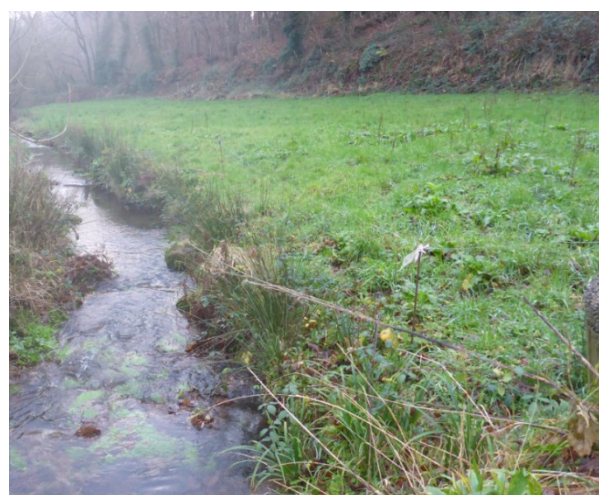
Rive droite : après les travaux
