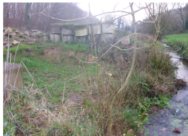
Rive gauche : avant les travaux
