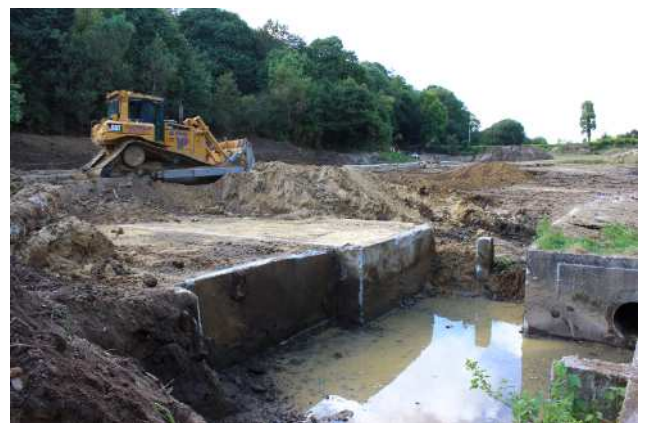
Suppression du remblai et des bassins de la pisciculture
