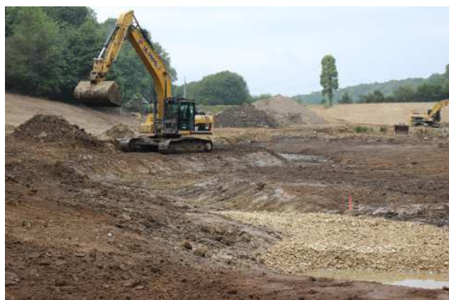
Reconstitution du sol de la zone humide et du lit du cours d'eau
