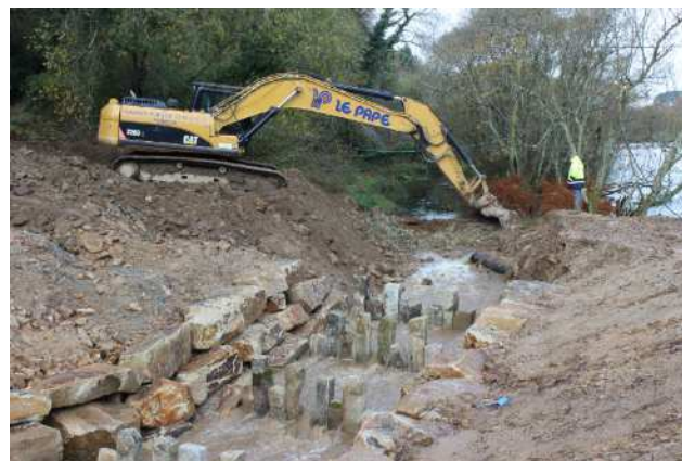
Déconnexion du cours d'eau du plan d'eau en amont de la rampe rugueuse
