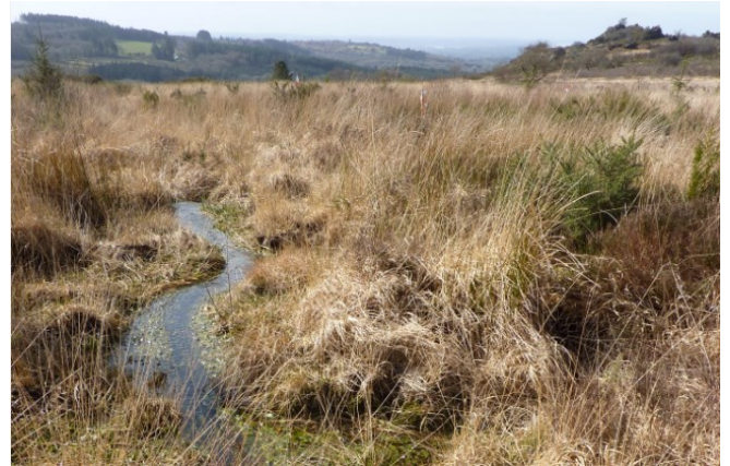
Site avant travaux présentant des fossés de drainage profonds
