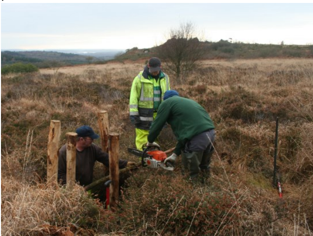
Mise en place d'une fascine par l'équipe du chantier d'insertion
