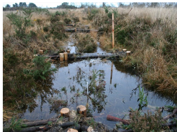
Succession de fascines sur un fossé quelques jours après leur mise en place : le niveau de la nappe remonte déjà.
