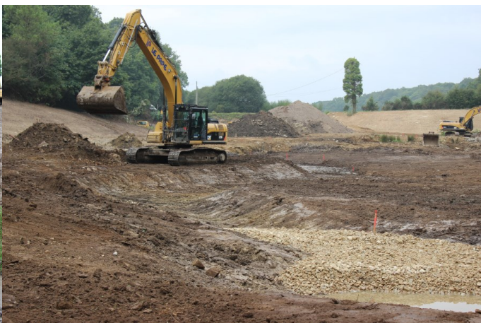
Suppression des bassins et remodelage du sol et du nouveau lit du cours d'eau
