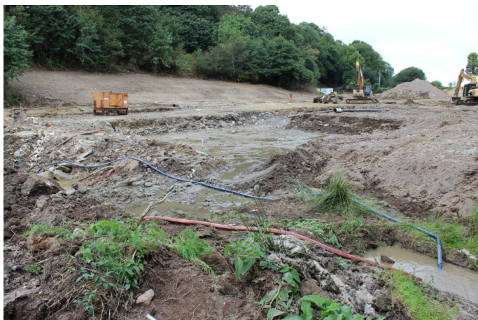
Suppression des bassins et remodelage du sol et du nouveau lit du cours d'eau
