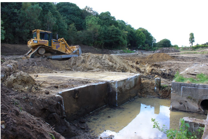
Suppression de la terre en surface des bassins puis dans les bassins
