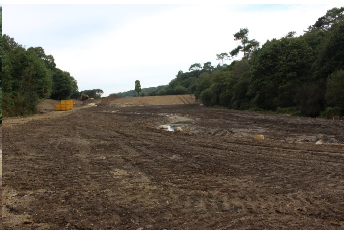
Suppression des bassins et remodelage du sol et du nouveau lit du cours d'eau
