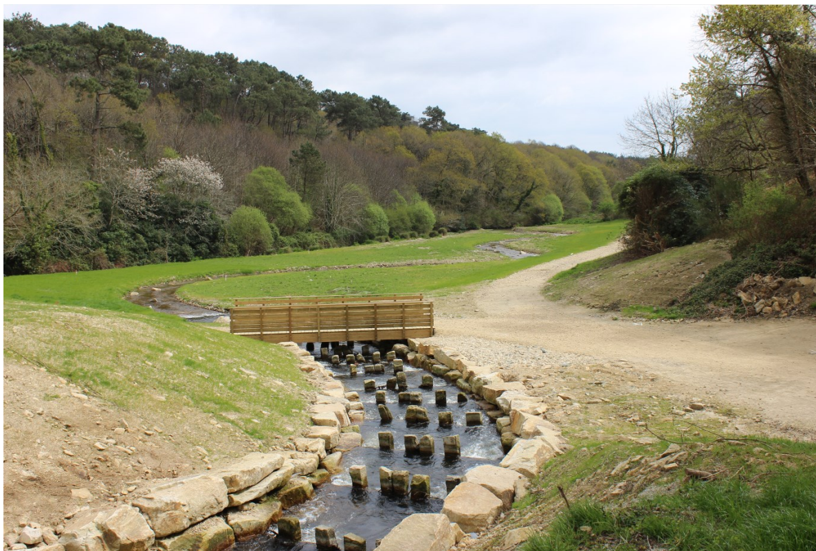
Vue du site en avril 2017, 6 mois après travaux.
