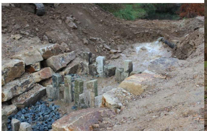
Ouverture du nouveau tracé du cours d'eau en amont de la passe à poisson et mise en eau du nouveau lit
