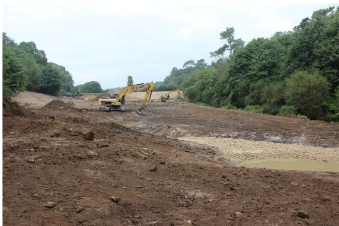
Progression des travaux d'aval en amont en une passe
