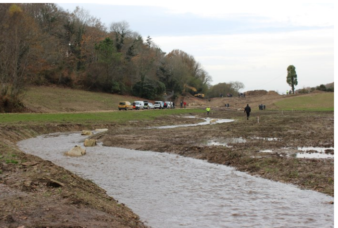
Ouverture du nouveau tracé du cours d'eau en amont de la passe à poisson et mise en eau du nouveau lit
