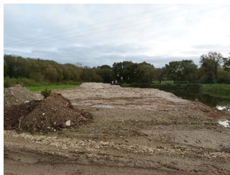
Travaux de remblaiement d'un bassin de lagunage.
