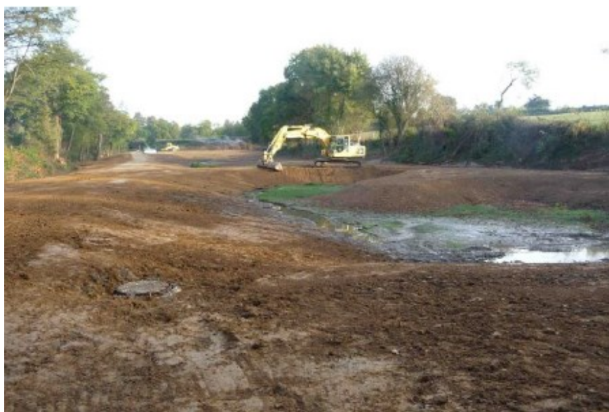
Reprofilage du fond de vallée sur le site des anciennes lagunes de Vignoc (35) © Laëtitia Citeau
