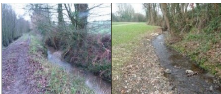
Avant / Après travaux
