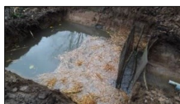
Bassin de décantation en sortie des eaux de vidange
