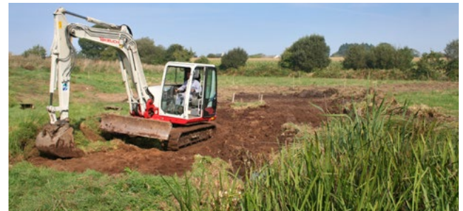
Comblement de fossés de drainage
